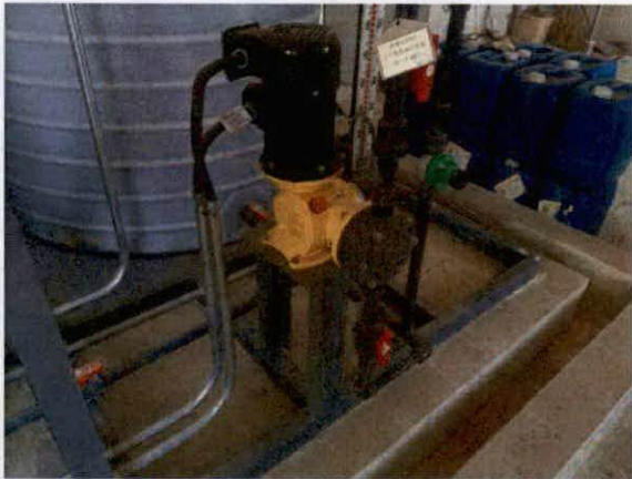
加药罐区围堰
