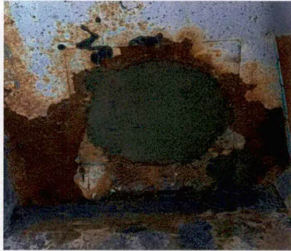
外排水排放口封堵
